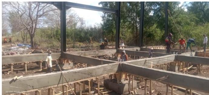
Gambar 4. proses pembangunan struktur baja Rumah Sakit Pratama
