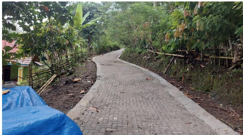
Gambar 3. Hasil Pembangunan Jalan
