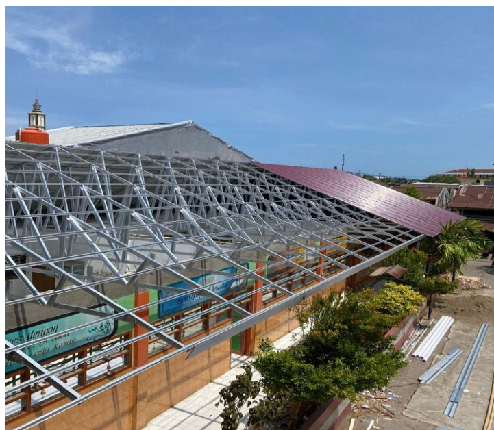
Gambar 6. Proses Pemasangan spandek
