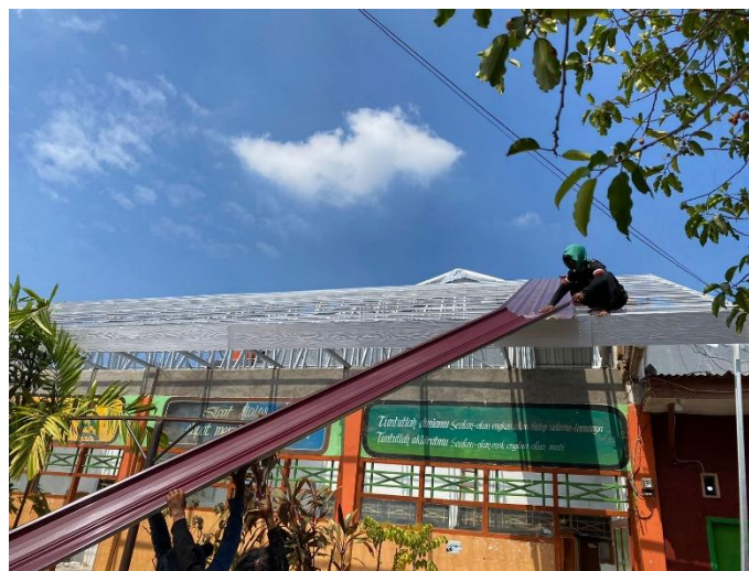
Gambar 5. Proses pengangkatan spandek dengan Panjang 3,5 meter
