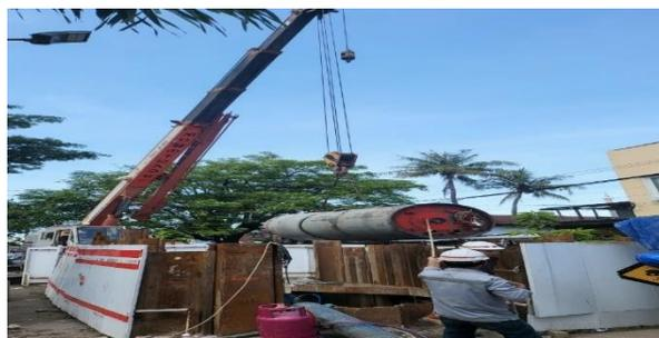
Gambar 3. Pengangkatan Alat Dorong Pipa
